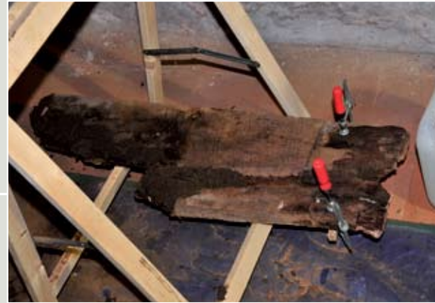
Verlijming en impregneren van vloerdeel
