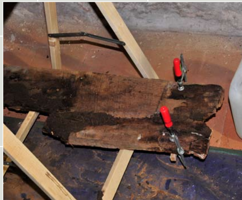
Gelijktijdig verlijmen en vullen van de planken
