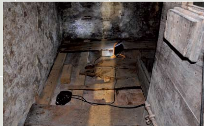
Terugplaatsing vloerdelen op nieuwe eiken onderlaag cel 10
