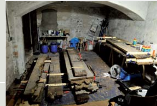
Inrichting werkplaats voor uitvoering restauratie in centrale ruimte van de kelders
